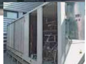
Grupo Farmacéutico Hefame, Getafe (Madrid) Enfriadora aire-agua compresor tornillo. Potencia instalada 960 kW. Climatización industria farmacéutica.
