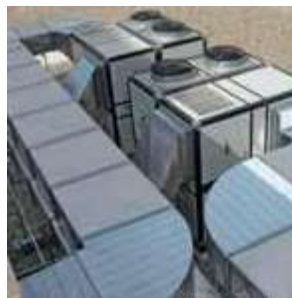
Parc d'Audiovisuals de Catalunya, Terrasa (Barcelona) Roof-top bomba de calor R410A.
