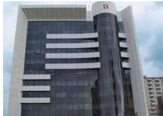
Capital Bank, Baku (Azerbaiyan) Sistema de caudal variable. Climatización.
