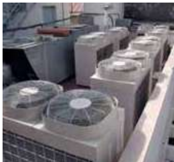
Hotel Dimar, Valencia Sistema de caudal variable.
