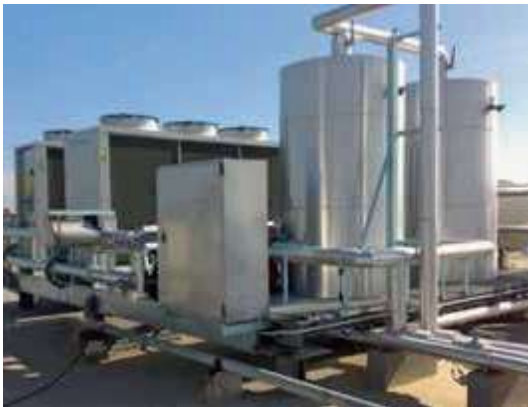
Hotel Cartagonova, Malgrat de Mar (Barcelona) Enfriadoras aire-agua con recuperación de calor. Potencia instalada 355 kW.
