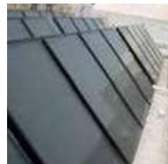
Piscina Municipal, La Oliva (Las Palmas) 75 Placas solares de alto rendimiento. Climatización piscina cubierta.
